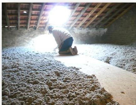
Ce procédé, le plus simple, consiste à dérouler une laine minérale ou bien déposer un isolant « Ouate de Cellulose » (voir photos ci contre) ou autre en vrac, sur toute la surface des combles.
