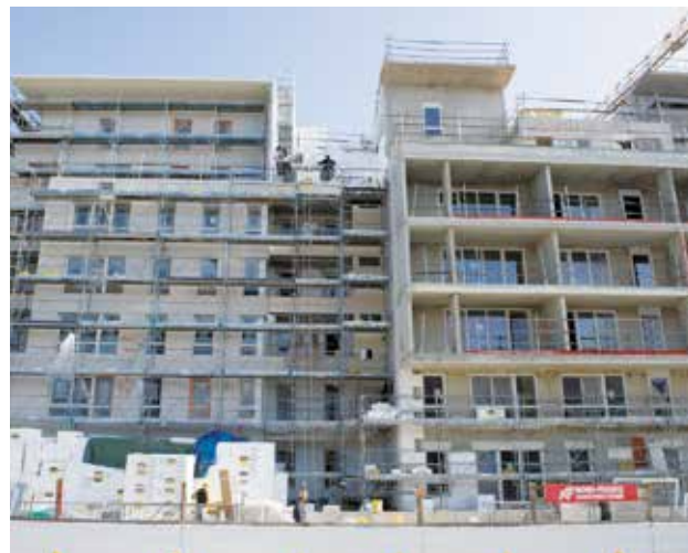
Pour être un projet réussi, un bâtiment doit être considéré dans son ensemble.
