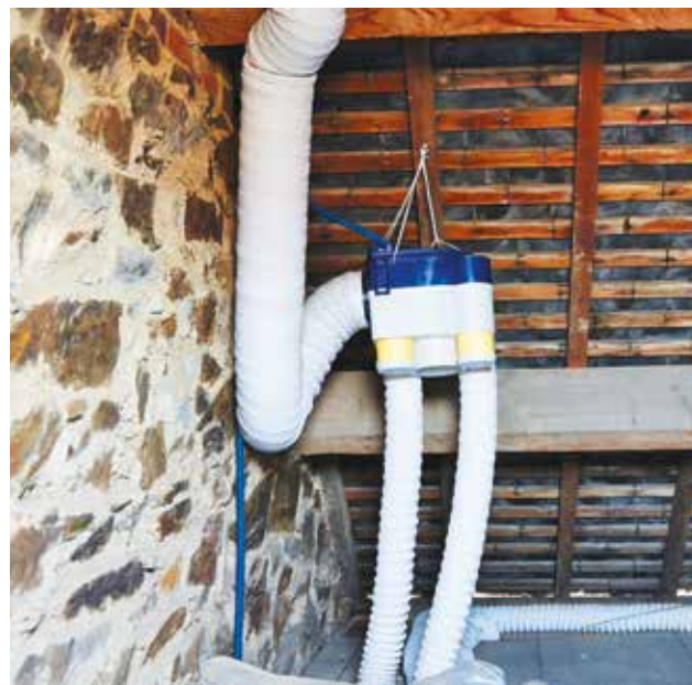
Le bruit d'une VMC peut être réduit grâce à une installation réfléchie, par exemple, dans une pièce inoccupée au moyen d'une suspension élastique.
