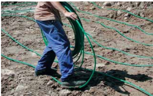
Pose de capteurs horizontaux.
