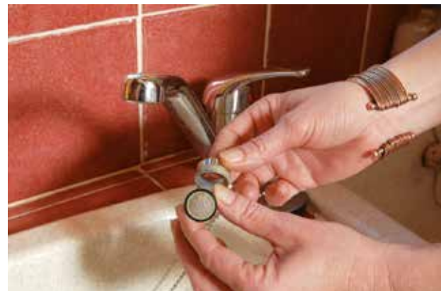
Certains aérateurs ou réducteurs de débit permettent de diminuer sensiblement le débit d'un robinet standard, avec le même confort d'utilisation.
